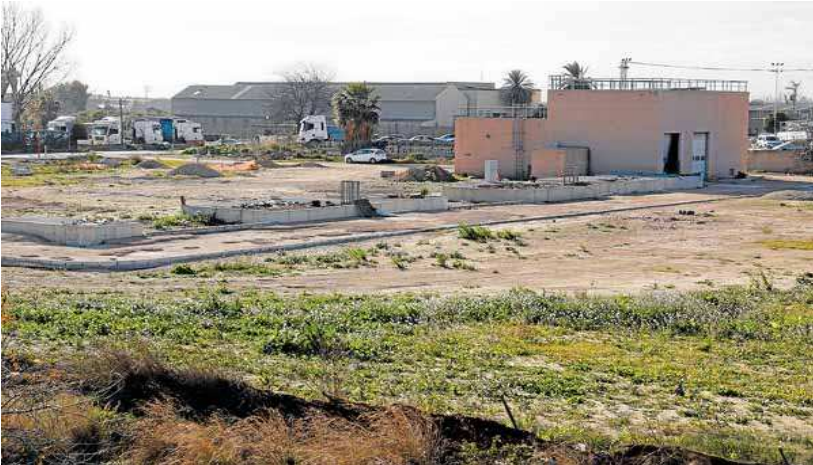
Los depósitos de tormenta junto a la Pista de Silla. JESÚS SIGNES
